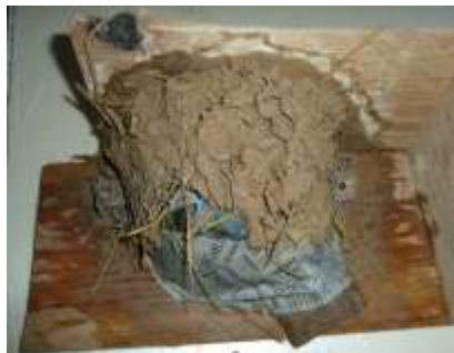
5 Kaninchendr. als Armierung in Lehmschicht einarbeiten.
