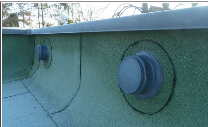
Reinigungs - und Kontrollöffnung DN125
