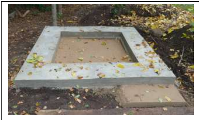
Das fertige Fundament
